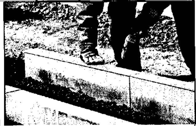
Установка или замена бордюрного камня
